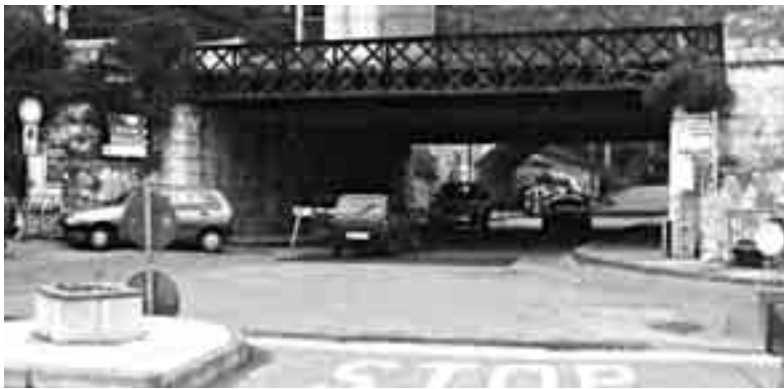
Un tratto della via S. Maria Goretti, bretella che collega la Ss 114 ai lungomari delle due località limitrofe: Letojanni e la frazione Mazzeo di Taormina
